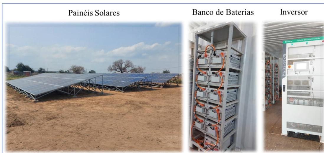
Figura 2.6.3-2: Componentes da MR da ARC Power em Maqueze
