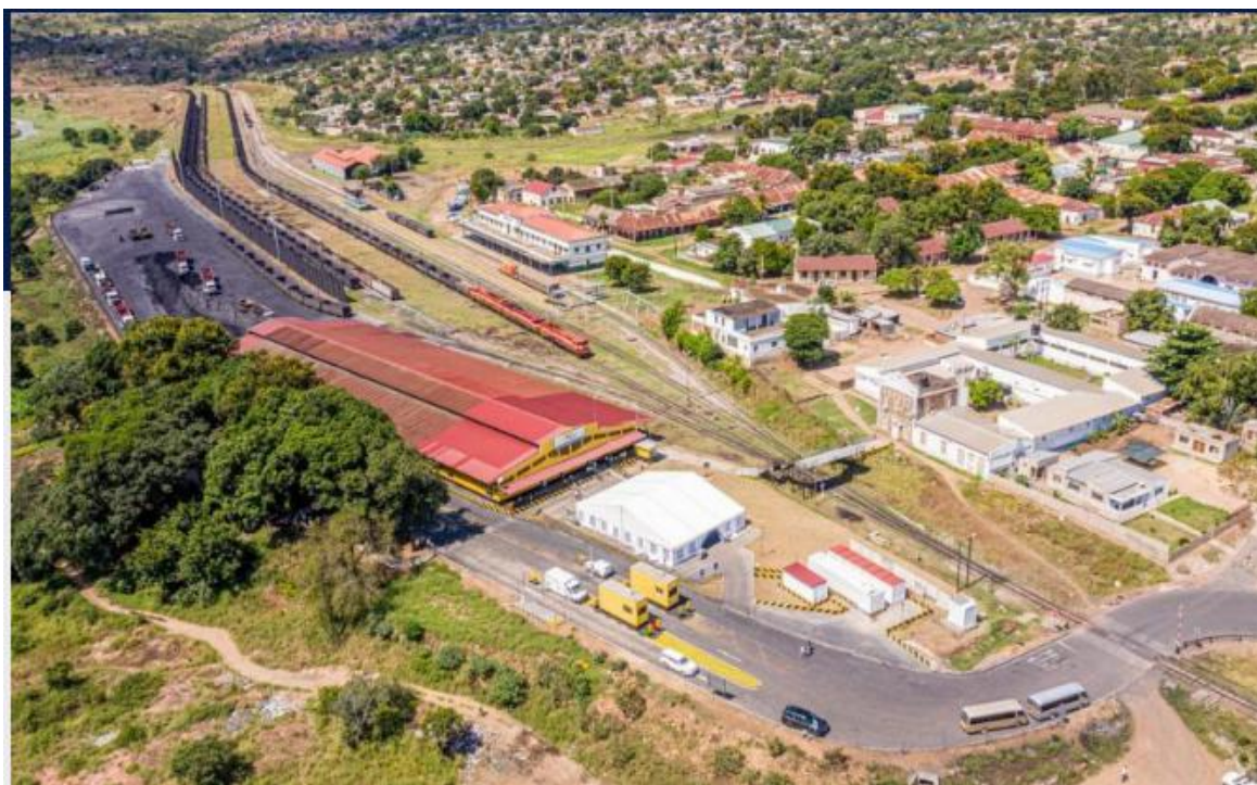
Figura 9: Vista aérea do Porto Seco de Ressano Garcia (Maputo)
