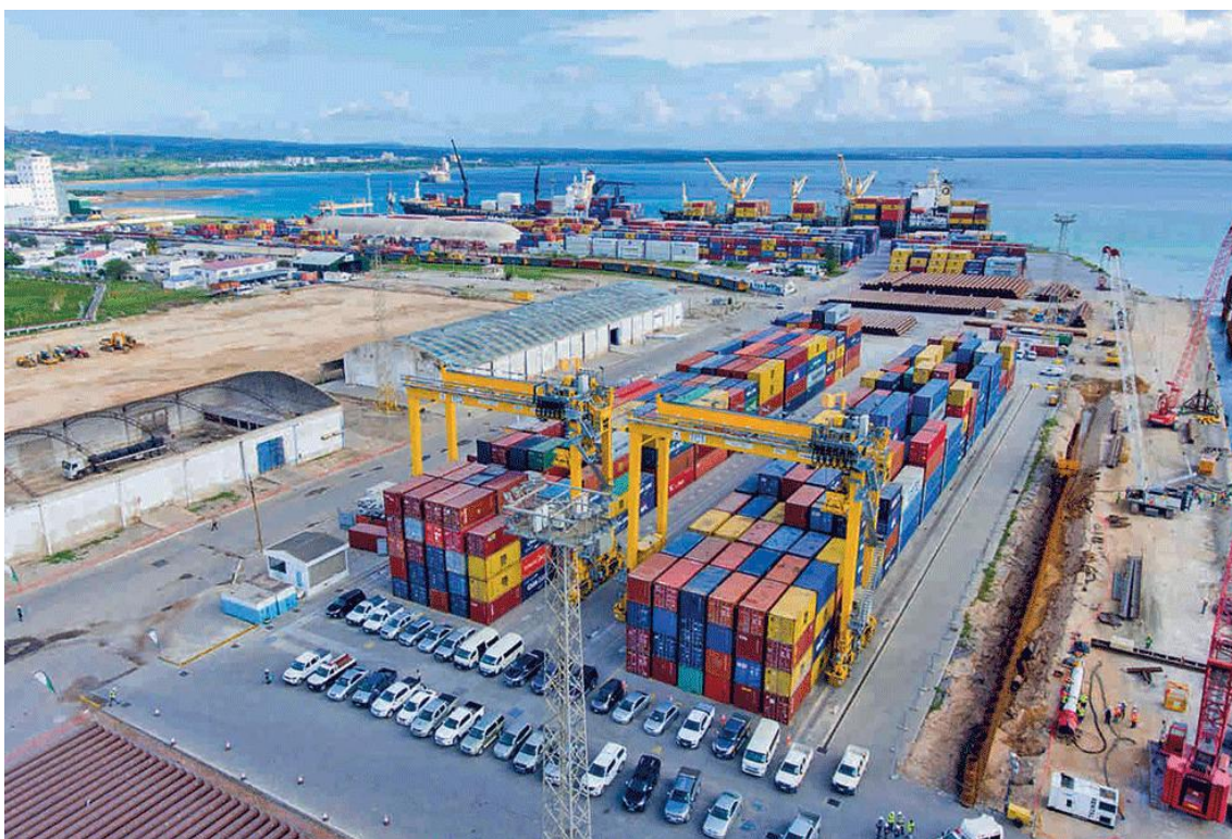
Figura 6: Vista parcial do porto marítimo de Maputo
