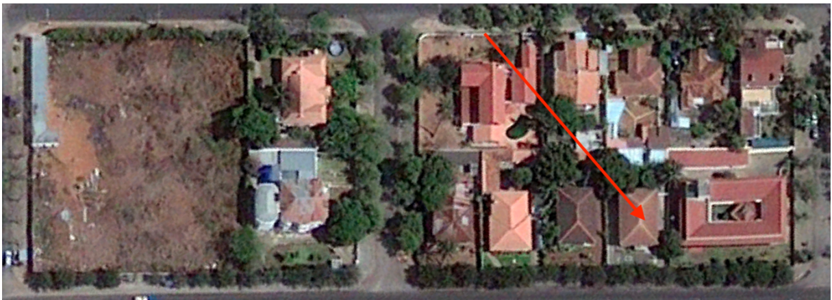
Figura 14 - Caso 2 – Situação antes da construção 2009 - Foto Google Earth 2023
