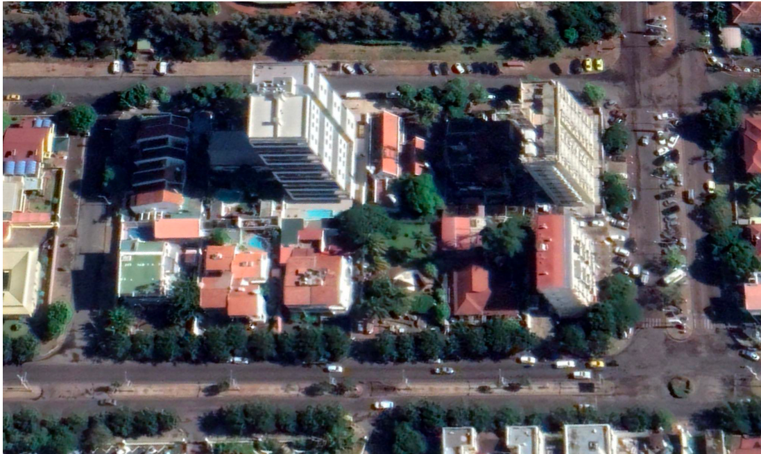
Figura 9 - Edifício Armando Tivane, 1384 – Foto Google Earth, 2022
