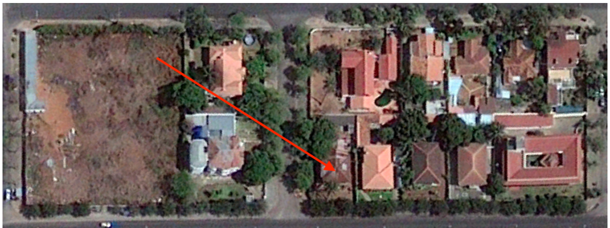
Figura 21 - Caso 4 – Situação antes da construção 2009 - Foto Google Earth 2022
