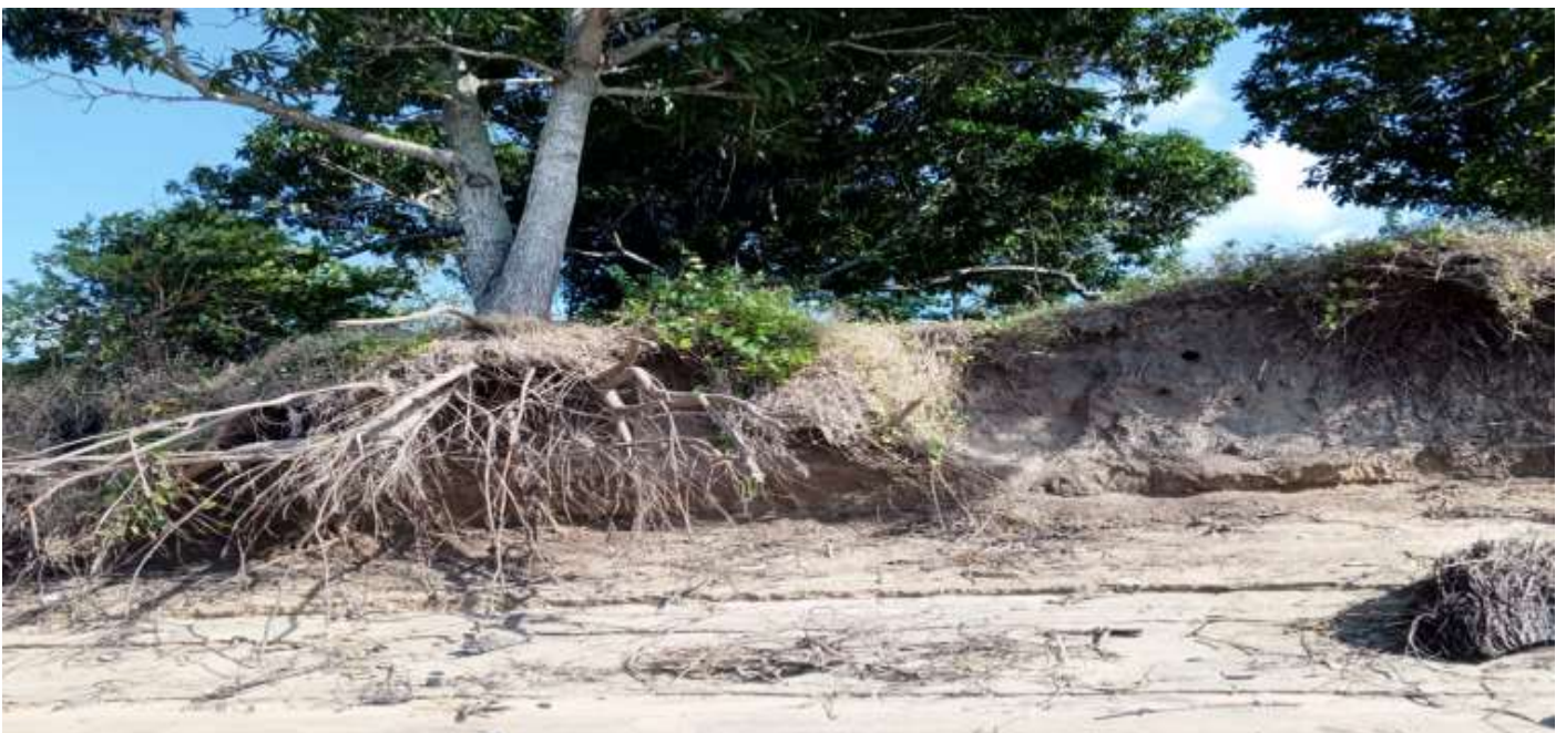
Figura 112. Impacto de erosão na região de Machilua
