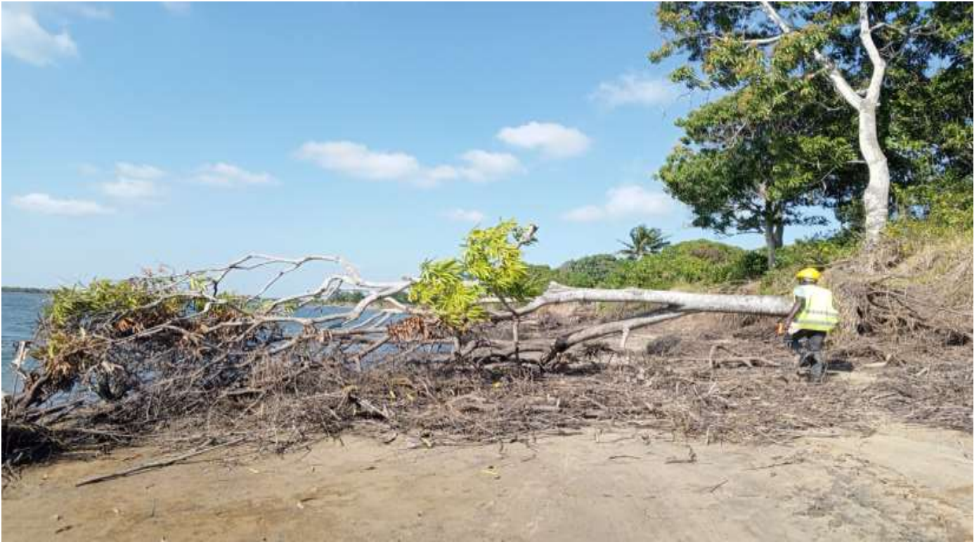
Figura 111. Impacto de erosão na região de Namitange
