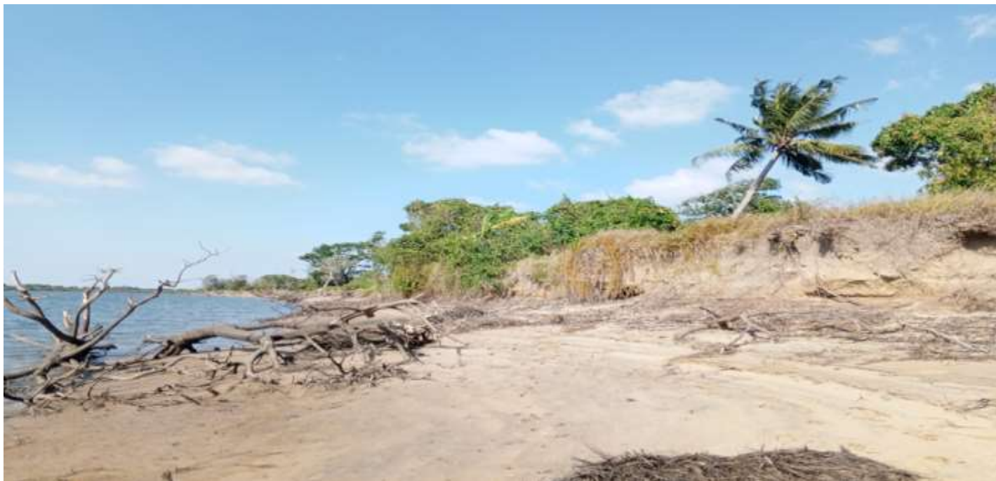
Figura 113. Impacto de erosão na região de 1º de Maio
