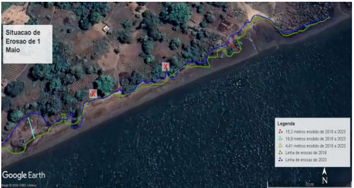
Figura 99. Situação de erosão de 2018 á 2023 na região do 1º de Maio
