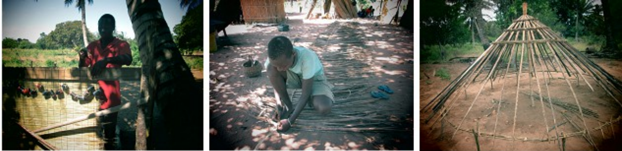
Figura 6 – Processo de fabrico de esteira e de tecelagem de folhas de coqueiro para cobertura de palhotas
