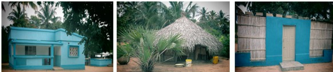
Figura 9 – Habitações coexistentes na povoação, nomeadamente, alvenaria, palhota simples e madeira e zinco
