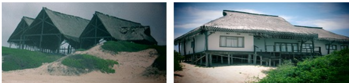
Figura 8 – uma casa na fase de construção e outra já concluída no complexo Canda 2
