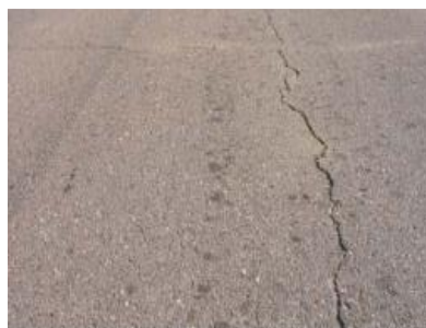
Trinca longitudinal
