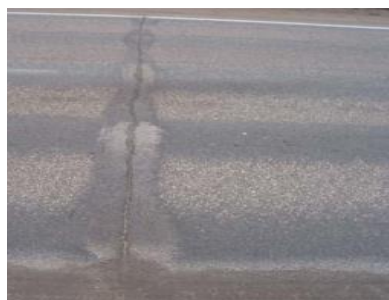
Trinca transversal
